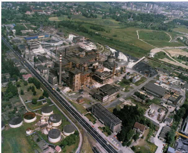
Fot. 14. Widok ogólny na fabrykę sody przed rozpoczęciem demontażu i wyburzeniem (1992; ze zbiorów prywatnych R. Pody)
