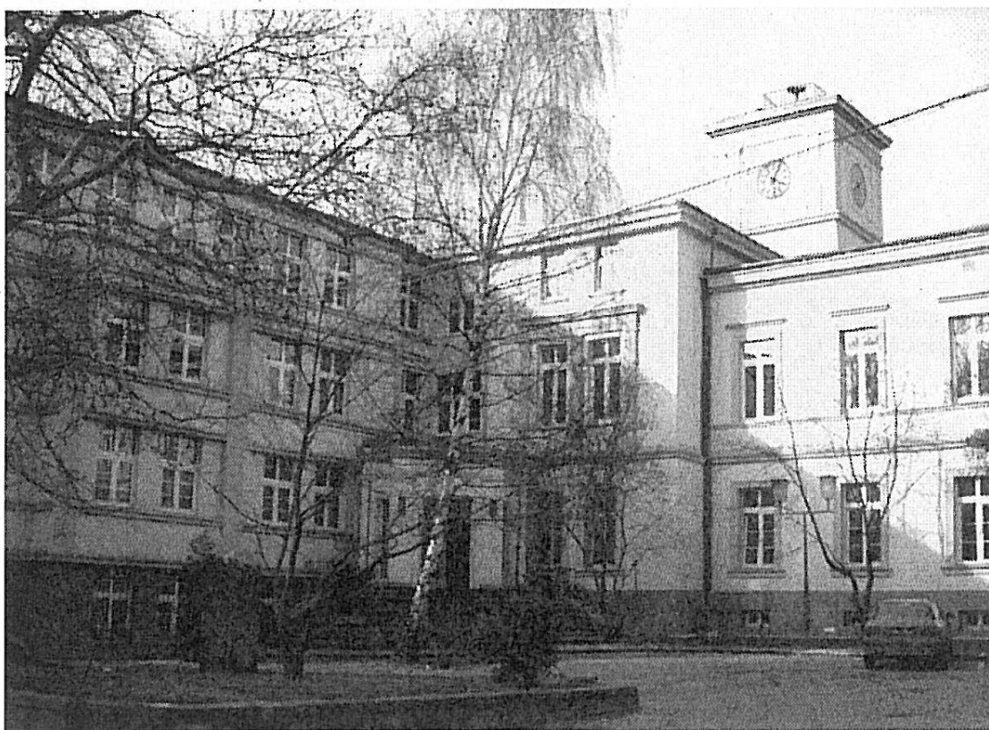
Budynek główny Instytutu
