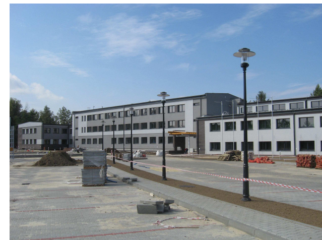
Budynki KWK „Wawel” w Rudzie Śląskiej - odnowione przez Śląski Part Przemysłowo-Technologiczny
