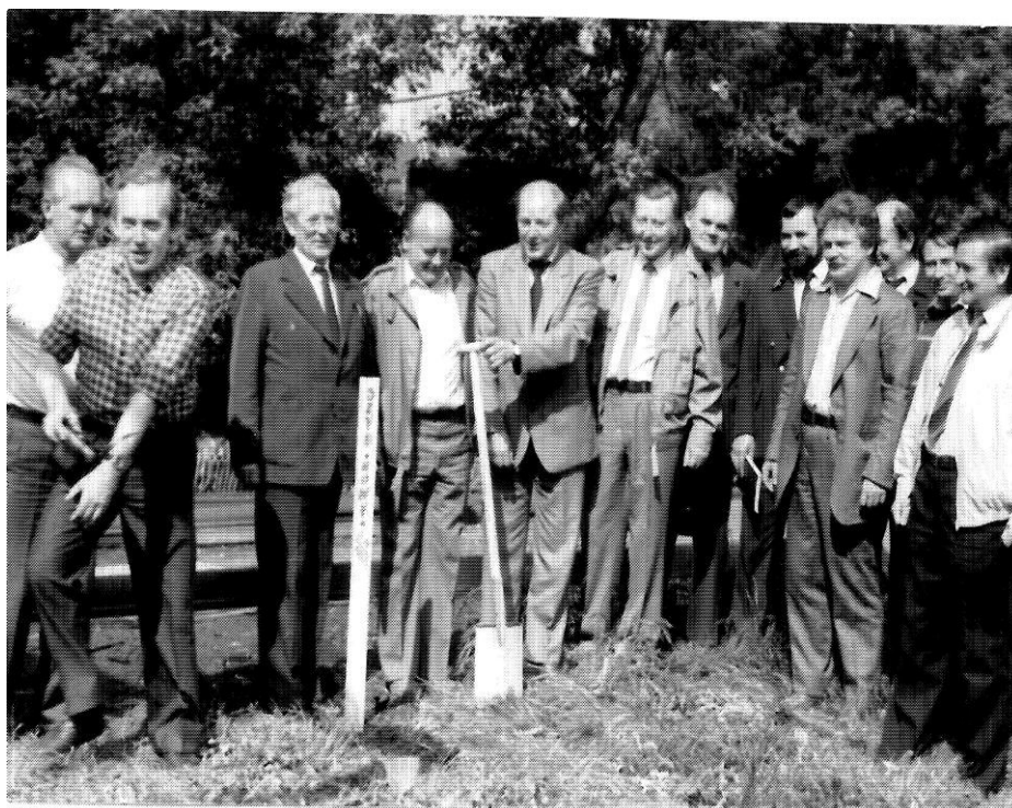
Zdjęcie 2. Oś szybu zaznaczona a ja podają łopatę by wykonać tradycyjnie pierwszy sztych
