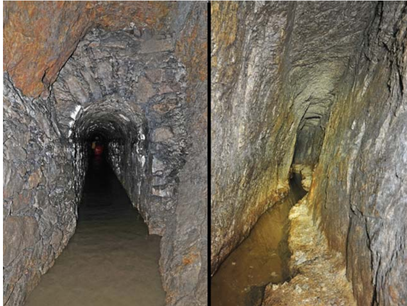
Rys. 7 i 8. Współczesne zdjęcia sztolni Emanuel . Po lewej fragment kamiennej obudowy sztolni, po prawej pochylony fragment sztolni (fot. M. Furmankiewicz) Fig. 7 i 8. Temporary photos of the Emanuel adit. Left – part of the adit with stone walls, right – inclined part of the adit. (phot. M. Furmankiewicz)
