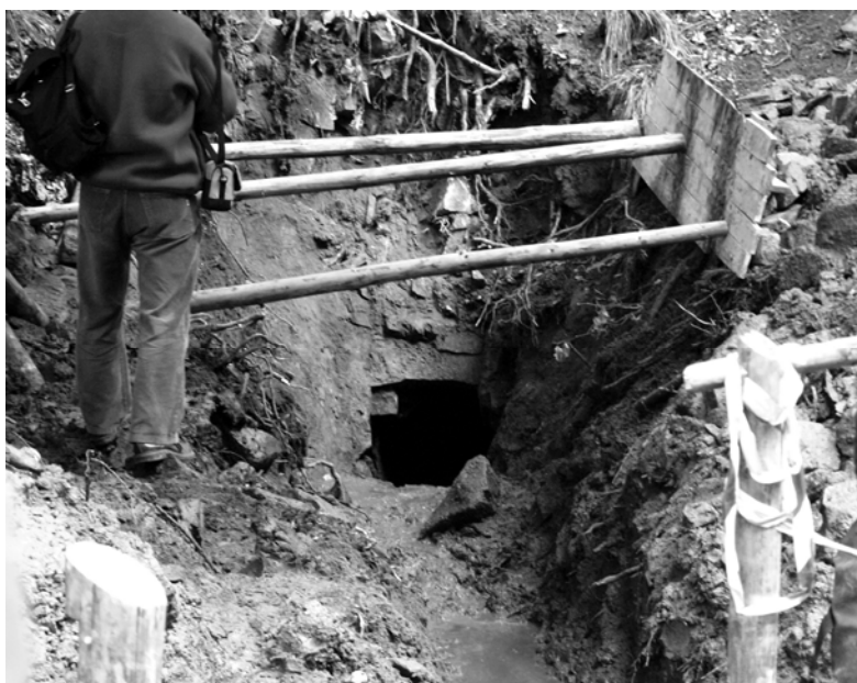
Rys. 1. Odkopany wlot sztolni
