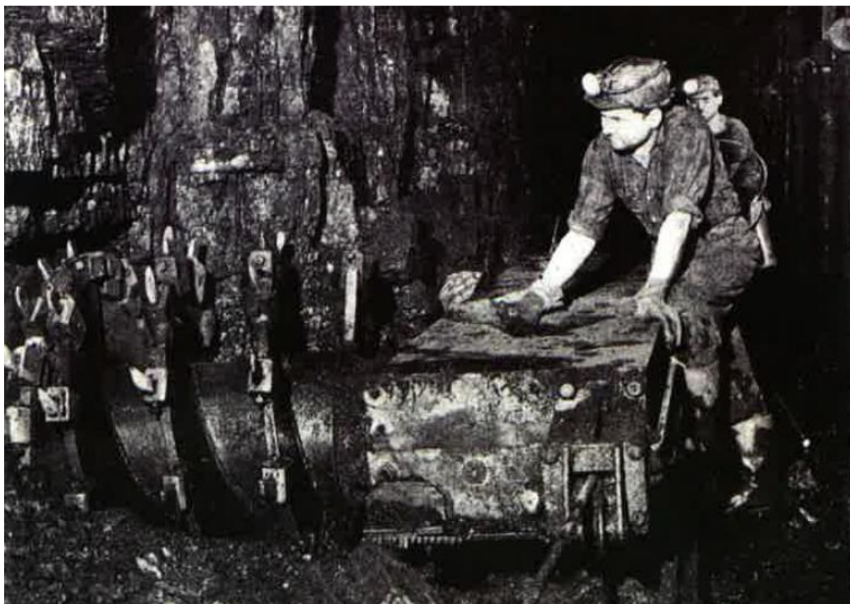
Produkowany seryjnie w Piotrowickiej Fabryce Maszyn Górniczych kombajn węglowy KWB-2 przy pracy (już ze ślimakowym organem urabiającym).
