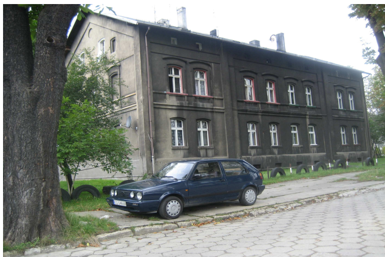
Fot. 1. Budynek byłej Dyrekcji kopalni „Waterloo” (fot. A. Kowalski)
