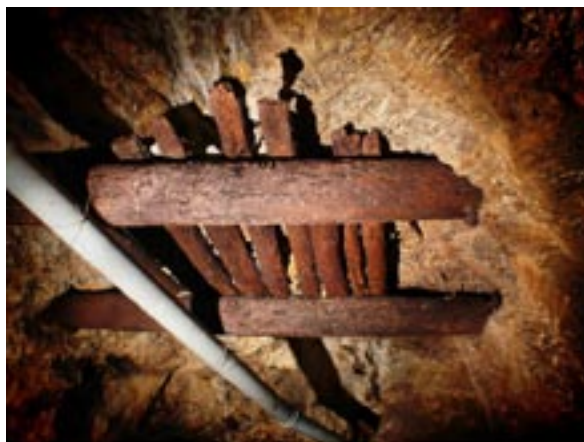
Ryc. 3. Sztolnia Amalie, zachowane drewno obudowy w stropie
