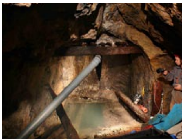
Ryc. 2. Sztolnia Amalie, komora szybu, zachowane fragmenty obudowy
