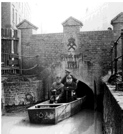
Rys. 10. Wylot sztolni w Zabrzu około roku 1953. Fig. 10. Outlet of the adit in Zabrze around 1953.
