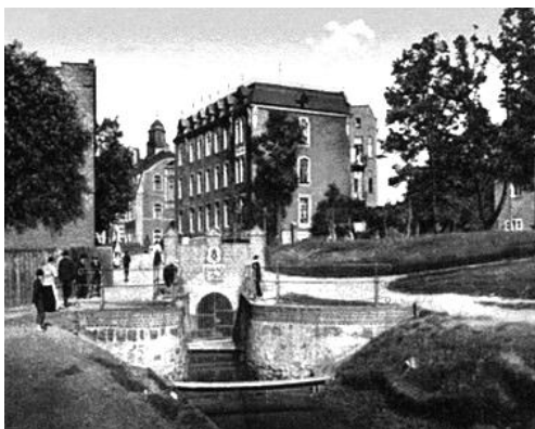
Rys. 2. Wylot Głównej Kluczowej Sztolni Dziedzicznej w Zabrzu. Fig. 2. Outlet of Main Hereditary Key Adit in Zabrze.
