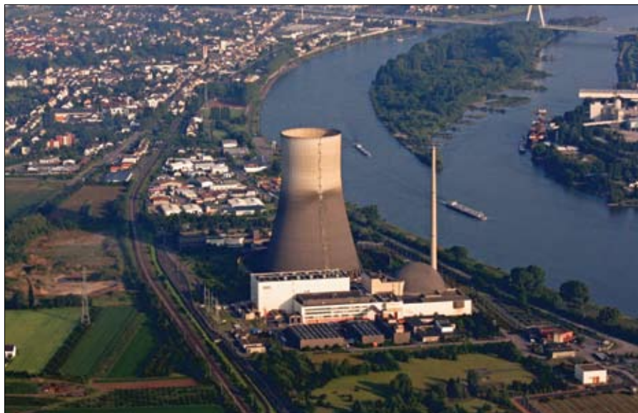
Elektrownia jądrowa Mülheim-Kärlich koło Koblenz zbudowana w rejonie szczeliny tektonicznej nad Renem. Z tych względów wstrzymano ruch w 1988 roku. Demontaż trwać będzie do 2018 roku (Opis elektrowni: Kres fascynacji, BG, nr 5-6/2003)
