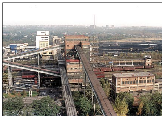
Kopalnia Sobieski. Budynki sortowni i odsiarczalni. Stan obecny
