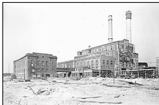
Budowa Elektrowni Jaworzno II. Rok 1953
