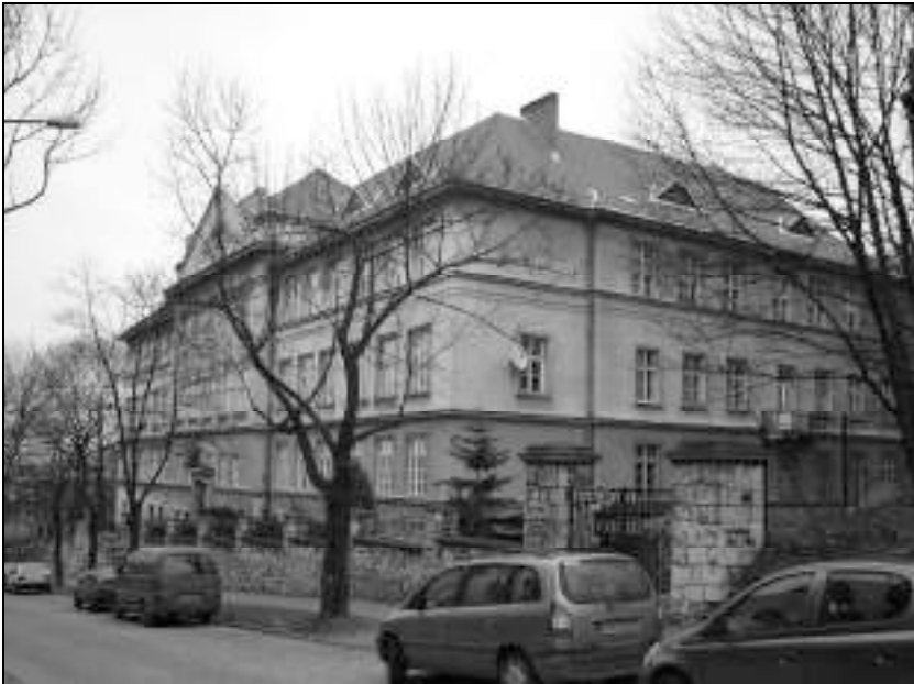
Fot. 10. Budynek odnowionego gmachu gimnazjum przy ul. Krzemionki z 1920 roku przekazany AG do użytkowania na wiele lat – stan aktualny (fot. A. Biedrzycka)
