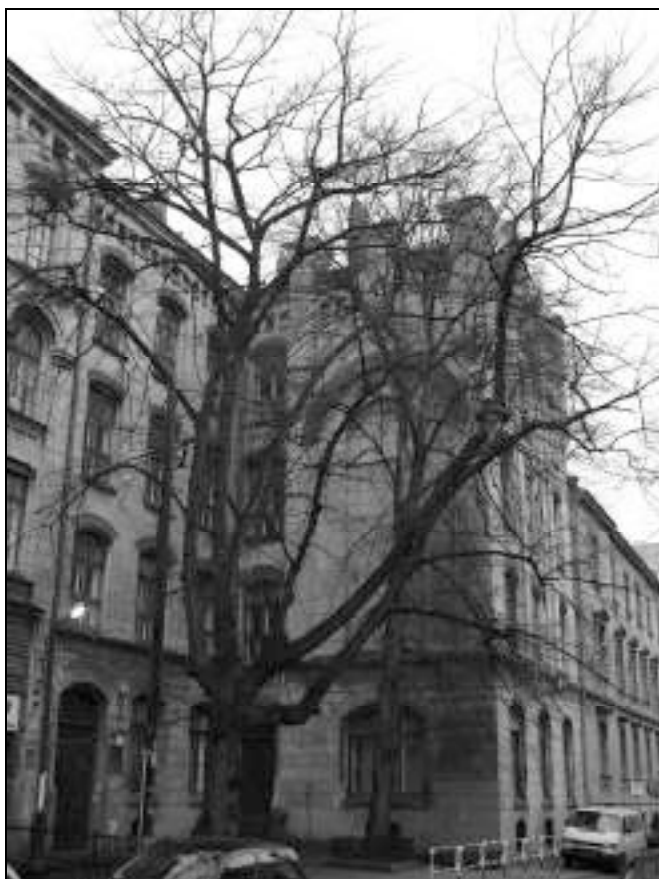
Fot. 7. Budynek przy ul. Loretańskiej 18 – stan aktualny (fot. A. Biedrzycka)
