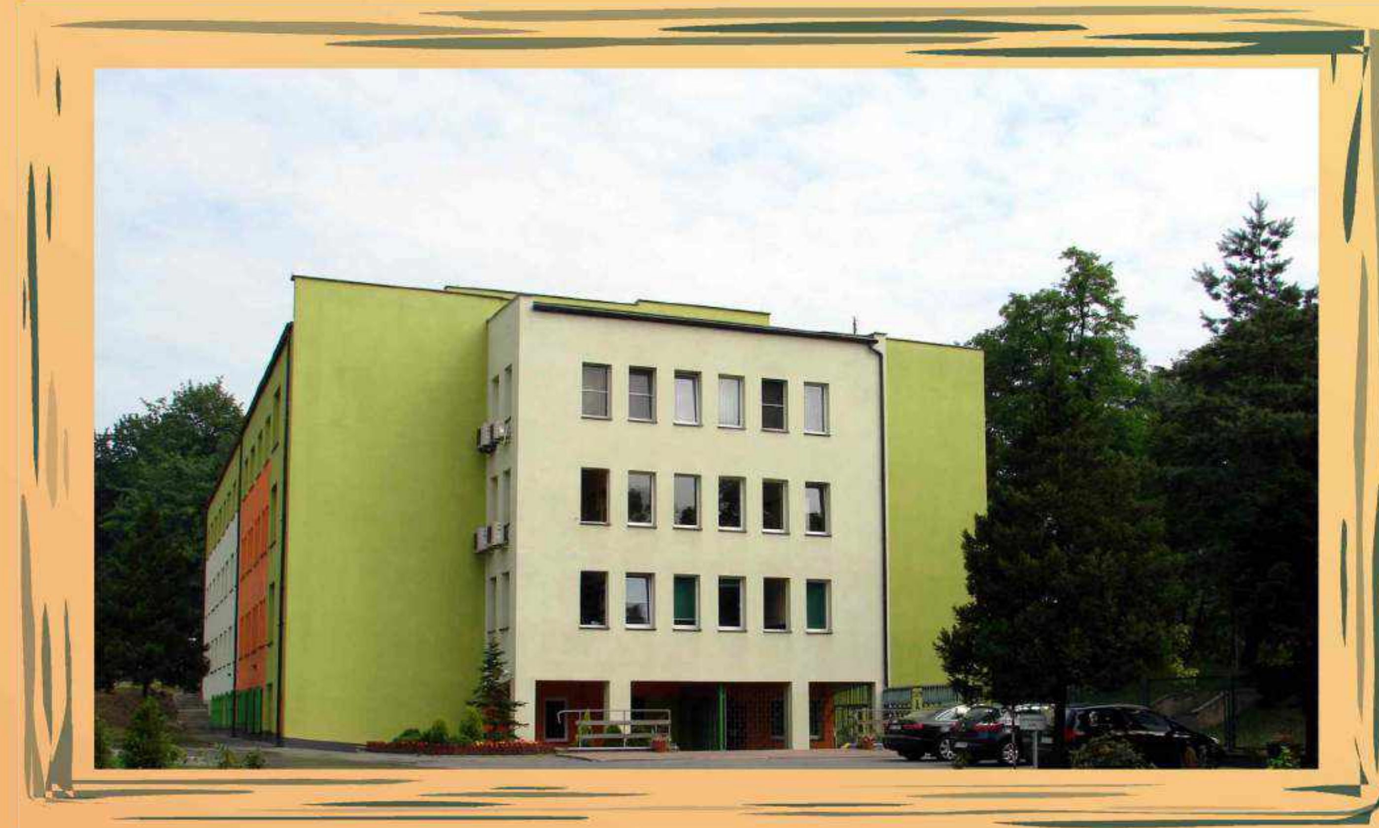
Kopalnia „Bolesław Śmiały” - budynek administracyjny
