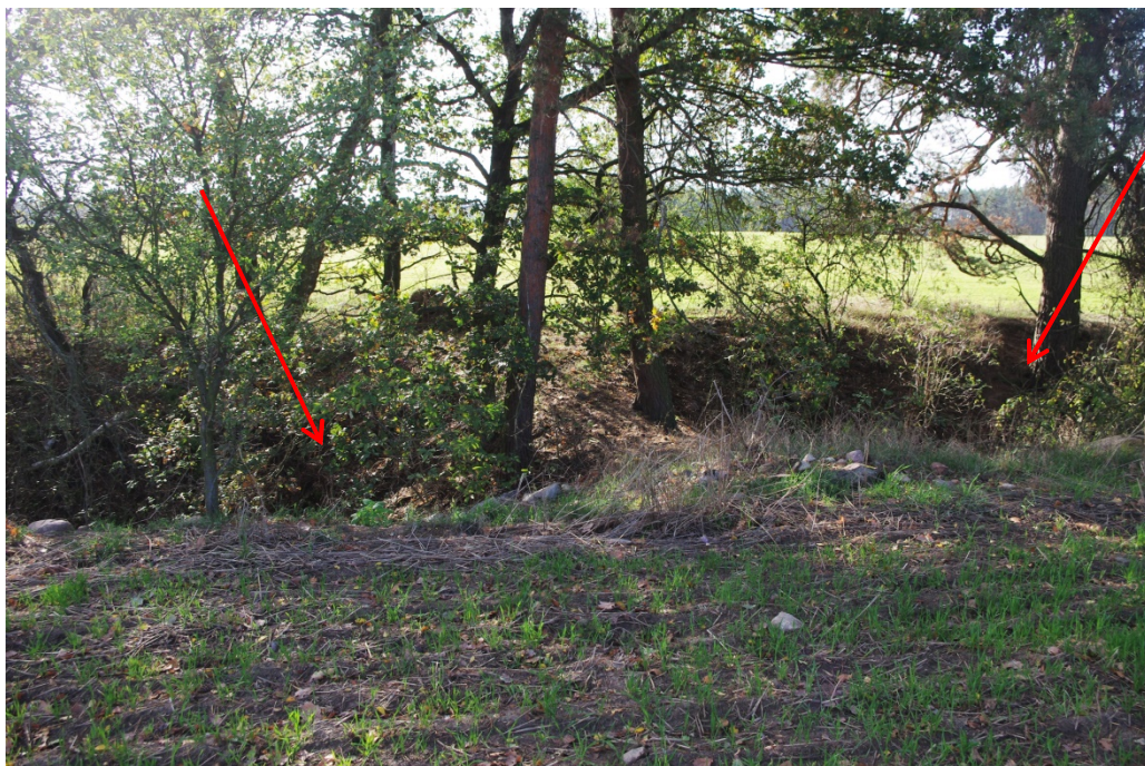
Ryc.21. Zapadliska nad komorami wydobywczymi kopalni „Graf Beust” przy drodze Lubrza - Rusinów. Strzałkami oznaczono komory, pomiędzy nimi widoczny filar z niewybranego węgla, 2019. Fot. autorka
