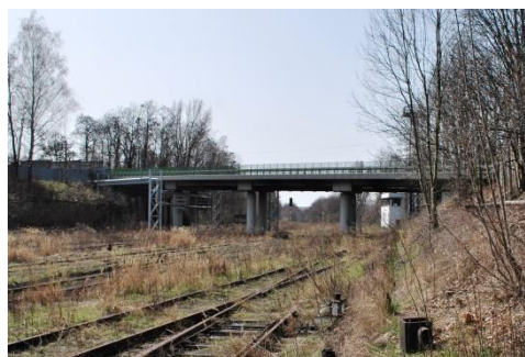
Rys.2. Wiadukt w Pszowie 2016 r.
