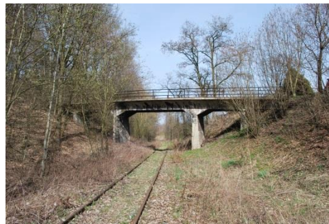
Rys.26. Wiadukt w Zawadzie 2016
