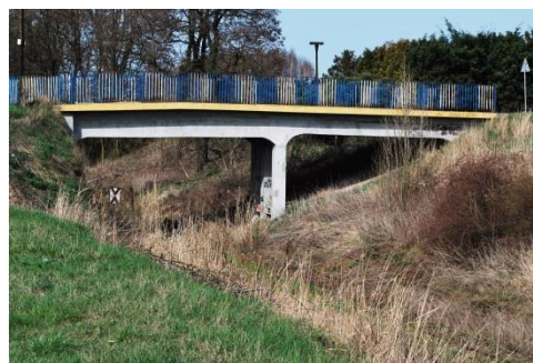
Rys.10. Wiadukt w Bluszczowie 2016 r.
