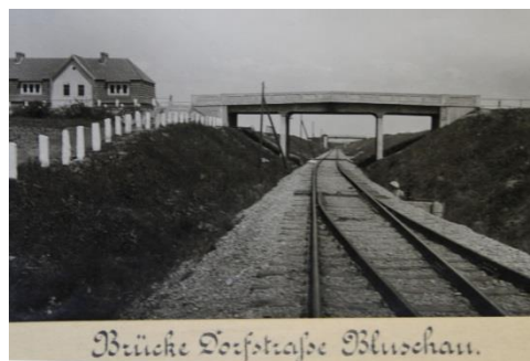
Rys.12. Wiadukt 2 w Bluszczowie 1917 r.
