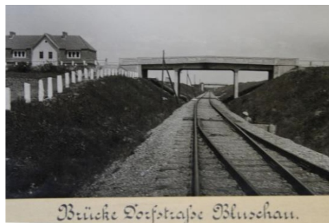
Rys.12. Wiadukt 2 w Bluszczowie 1917 r.
