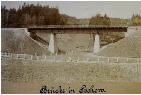
Rys. 27. Wiadukt w Pszowie w 1916 r.
