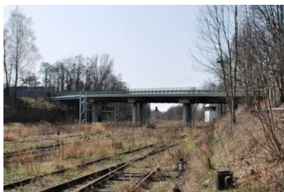
Rys.2. Wiadukt w Pszowie 2016 r.
