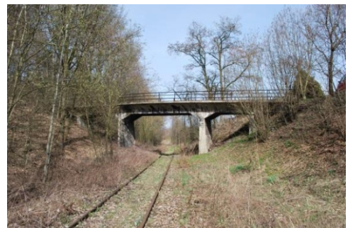
Rys.26. Wiadukt w Zawadzkie 2016 r.
