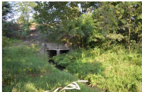
Rys.18. Przepust dla potoku Syrynka pod torowiskiem w miejscu mostu.
