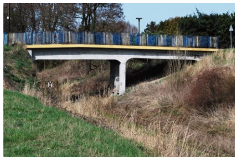
Rys.10. Wiadukt w Bluszczowie 2016 r.
