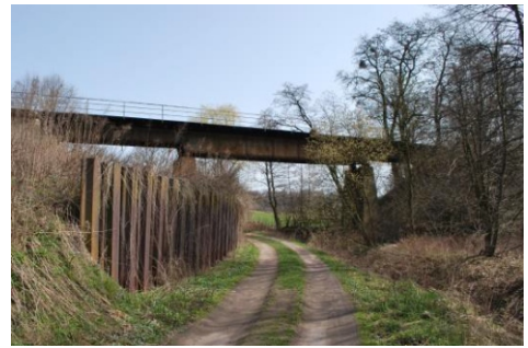
Rys.28. Wiadukt w Pszowie 2016 r.
