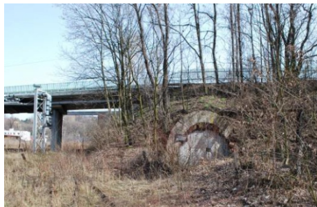
Rys. 3. Wiadukt w Pszowie z przepustem dla kolei wąskotorowej w 2016 r.
