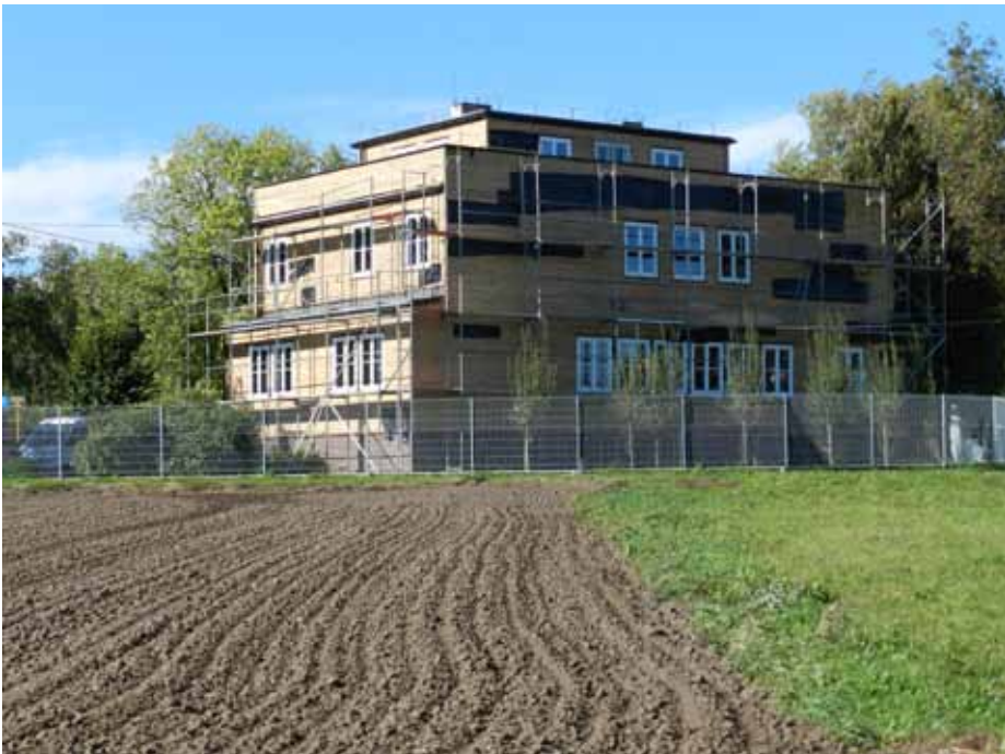
▣ Konserwacja elewacji budynku
