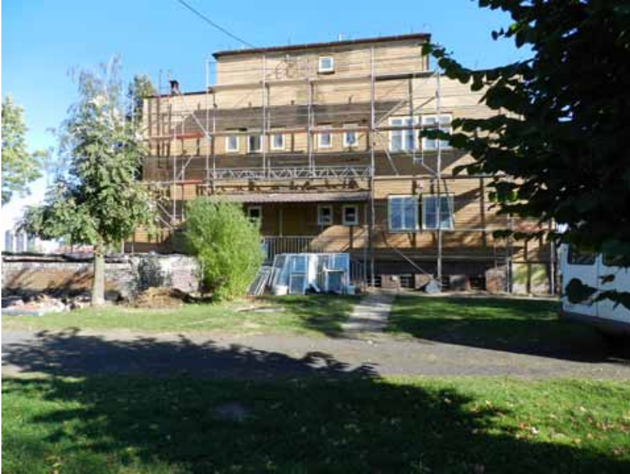
▣ Wymiana stolarki okiennej
