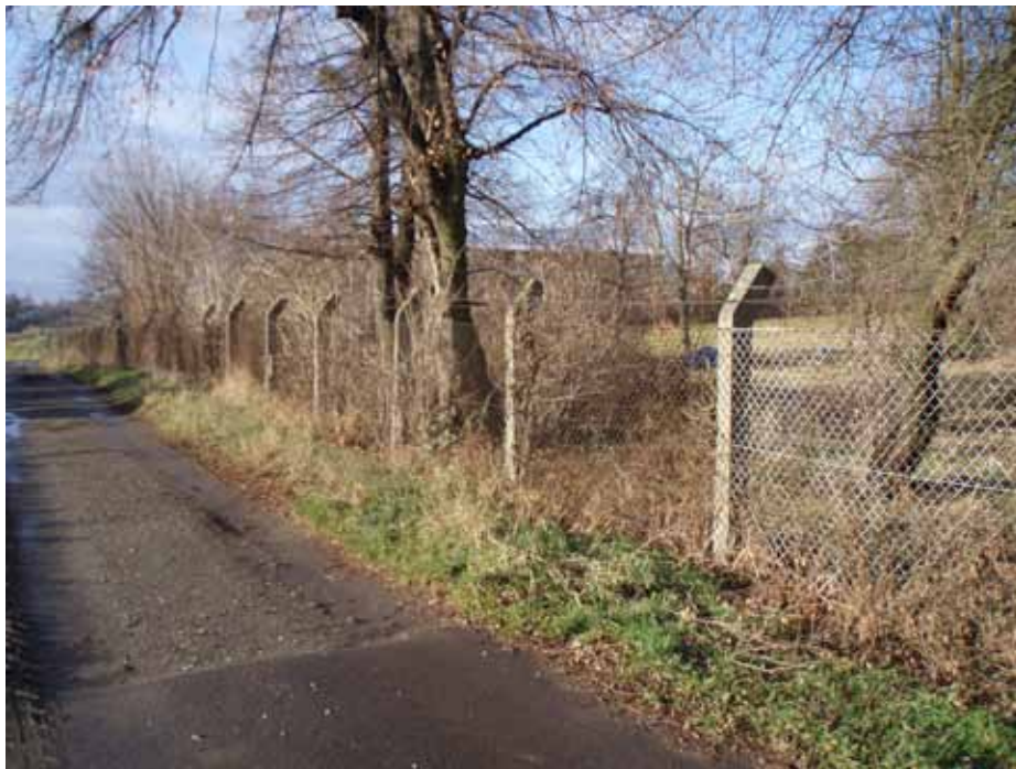
IGF PAN zlecił wykonanie nowego ogrodzenia obserwatorium. Stare Ogrodzenie
