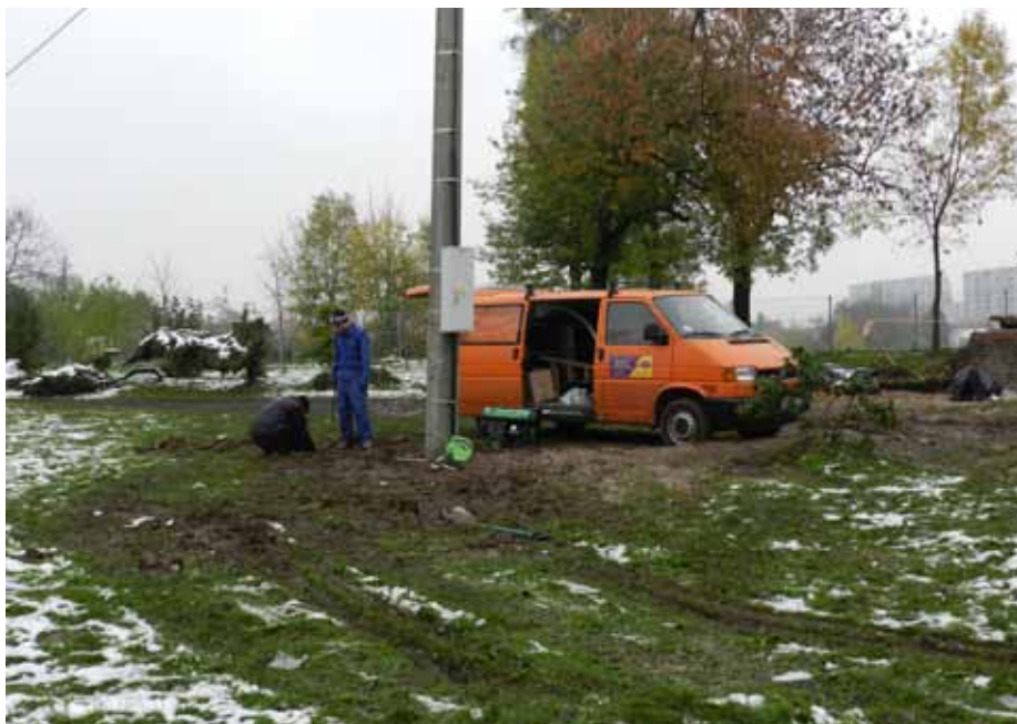
▣ Remont Instalacji elektrycznej zasilającej budynek
