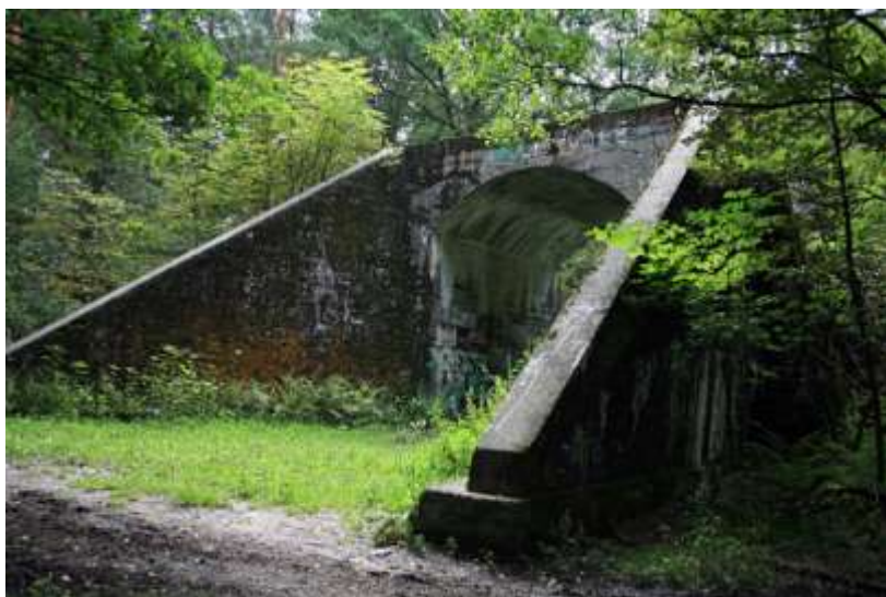
Rys. 2. Pozostawiony w lesie wiadukt kolejowy po niedokończonyj bocznicy kolejowej
