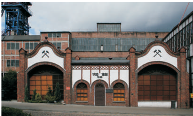
Budynek wagi w kopalni "Rydułtowy"
