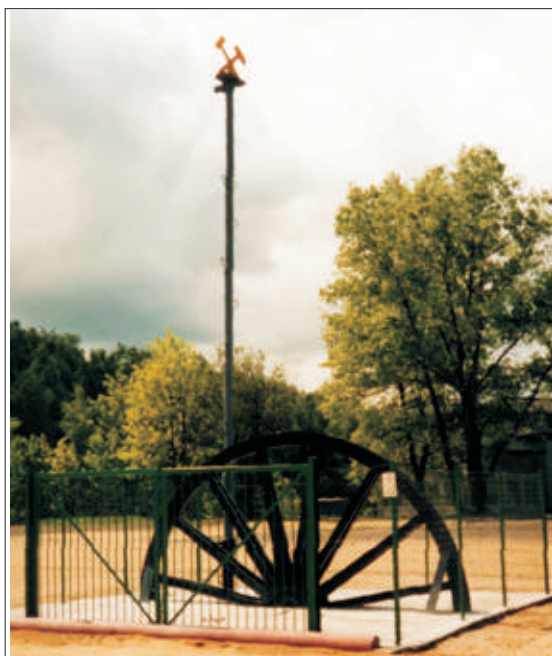
Maszt i koło linowe szybu na miejscu zlikwidowanego szybu K-I
