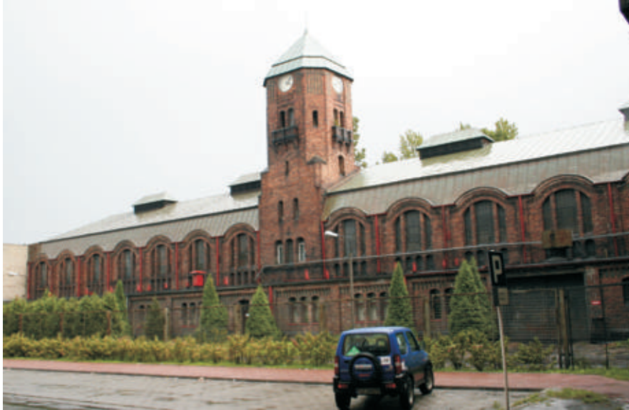
Budynek cechowni przy szybie "Pułaski", Katowice-Nikiszowiec
