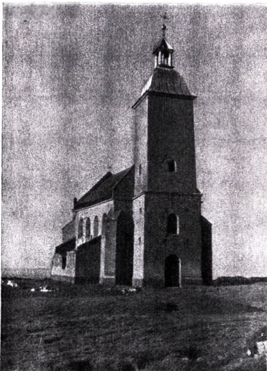
Kościół św. Doroty na szczycie erozyjnego wzniesienia triaso-wego
