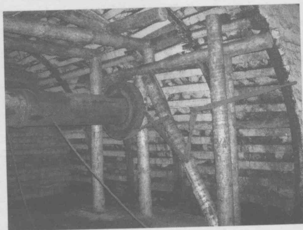
Stanowisko drewnianego kołowrotu pochylniowego (w budowie), poziom 320 w Zabytkowej Kopalni Węgla Kamiennego „Guido”. Fot. Tadeusz Loster
