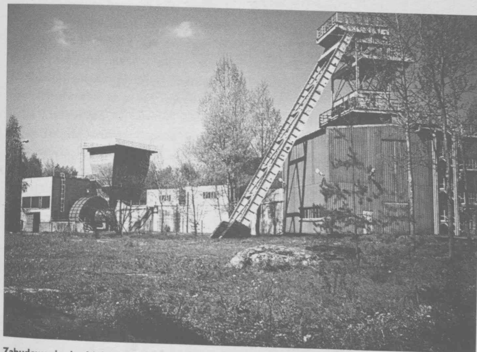
Zabudowania i obiekty szybu wentylacyjnego „Północny” kopalni „Sośnica-Makoszowy”, 2006 r., fot. Jan Woźniak
