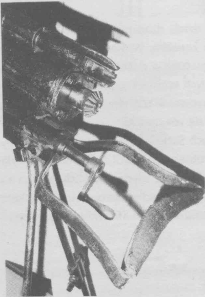
Ryc 9. Wiertarka Osterkamp rok produkcji 1882. Ze zbiorów Muzeum Górnictwa Węglowego w Zabrze
