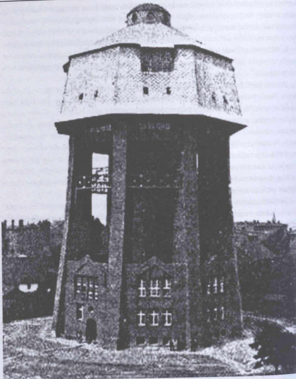
Wieża wodna w Zabrze z 1911 roku (stan w 1913 r)
