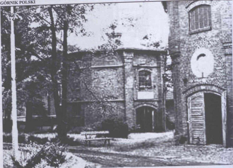
Zakład wodny Szyb „Staszic”, po prawej fragment szybu Maszynowego
